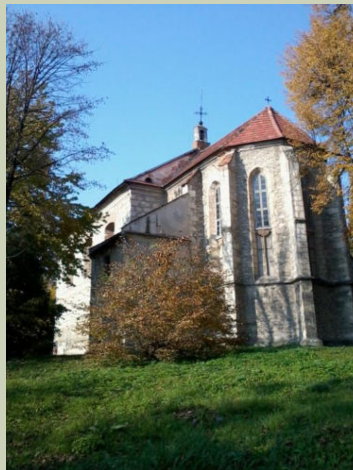
Il. 1. Budynek kościoła poklasztornego
